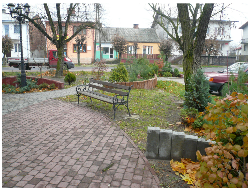
Fot3. Palisady betonowe w parku przy rynku przeznaczone do rozbiórki.
