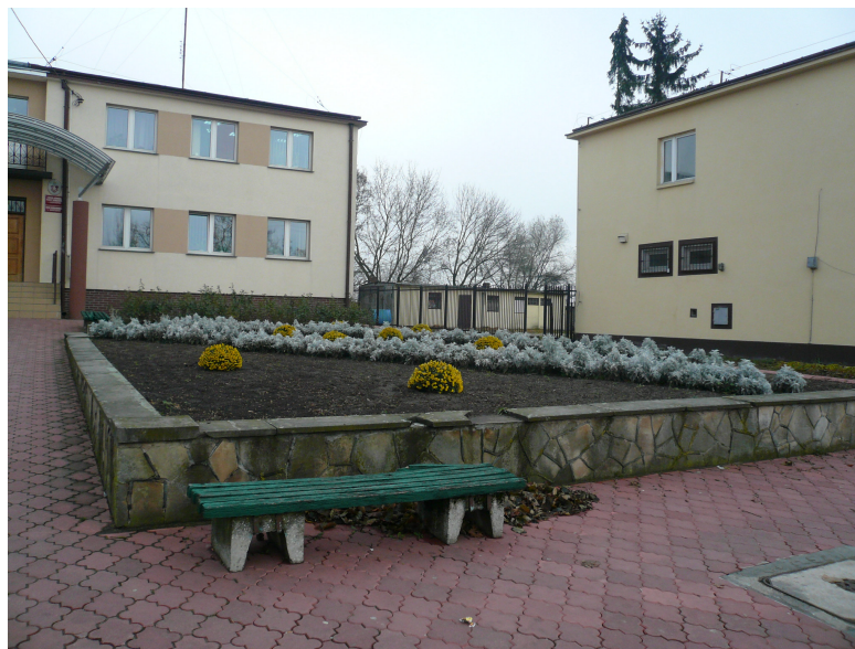
Fot1. Górna część murka przed Urzędem Gminy przewidziana do demontażu i zastąpienia nową okładziną z piaskowca
