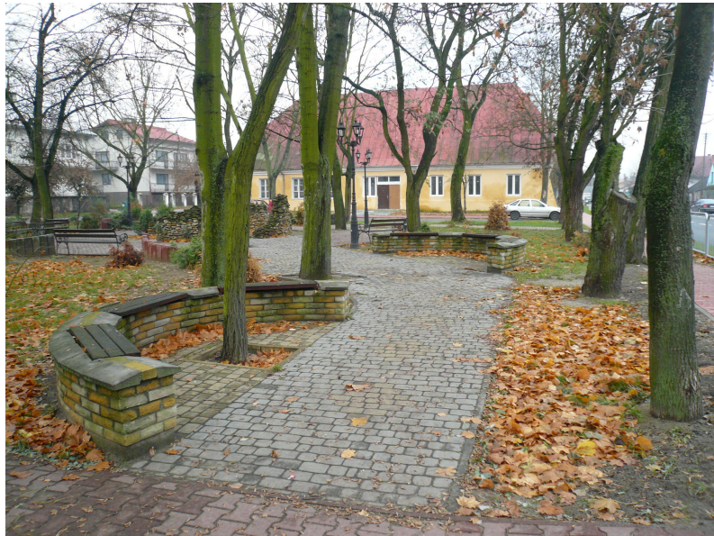
Fot4. Ławki w „półkolach” przeznaczone do renowacji.
