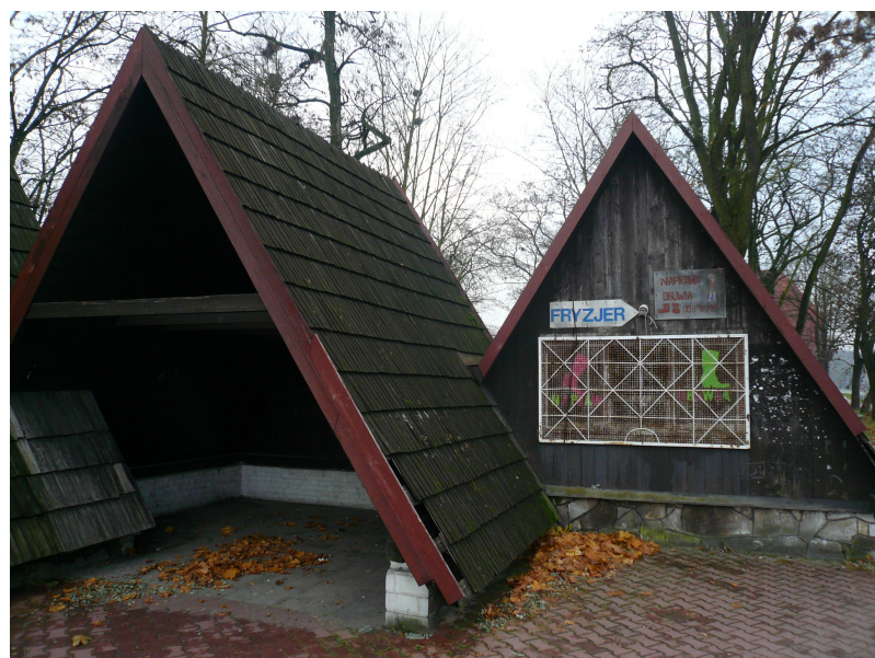
Fot6 i 7 . Wiaty przeznaczone do rozbiórki, ławki o podstawie betonowej do usunięcia.
