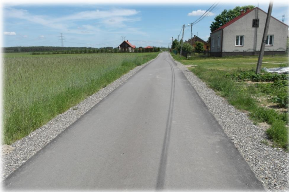
Droga bitumiczna w miejscowości Przydworzyce
