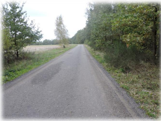
Droga o nawierzchni z destruktu łącząca Trzebień z Dębowolą
