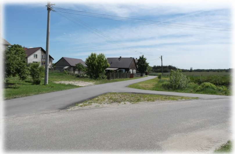
Droga bitumiczna w miejscowości Trzebień
